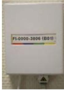
**Figure 6 : FTTE passif PM - exemple de PTO**
