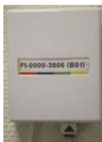
Figure 8 : FTTE passif NRO - exemple de PTO
